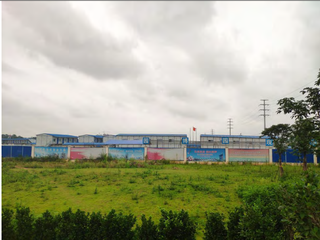
图 4.4-3 施工营地现状
