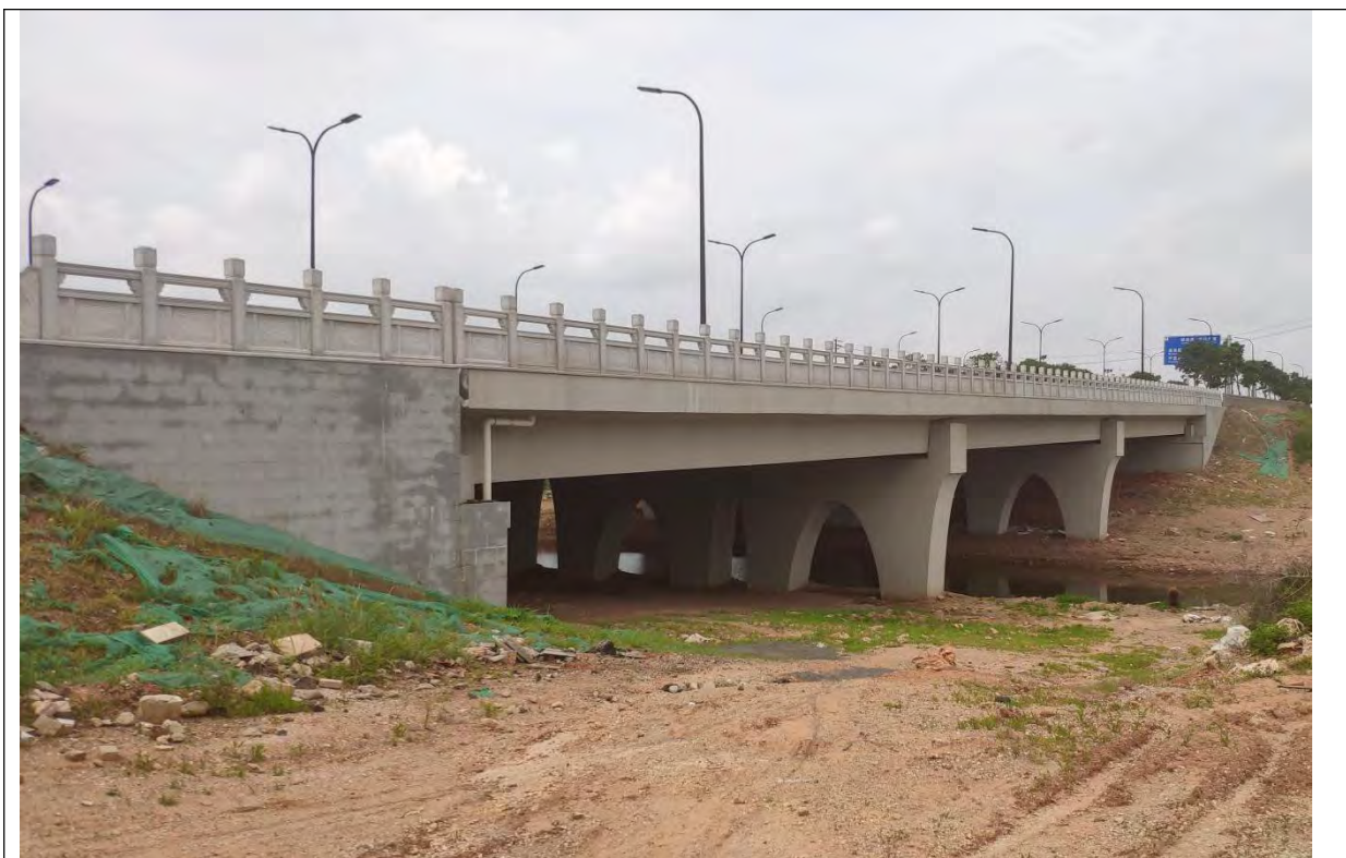
图 2.3-8 项目桥梁工程
