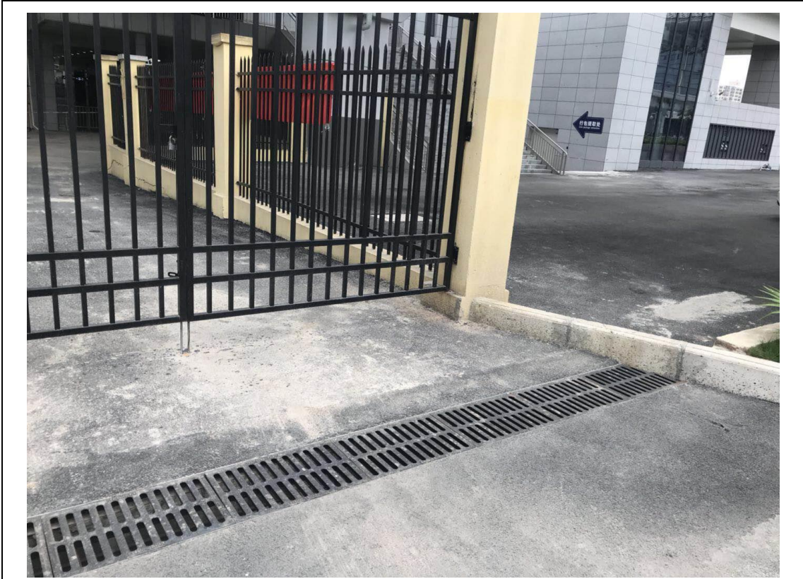
排水沟现状（一）
