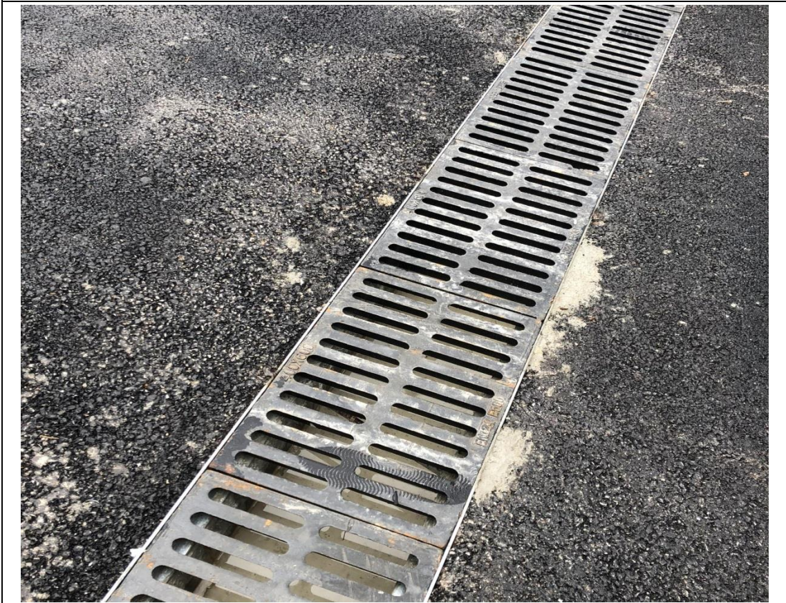
排水沟现状（二）
